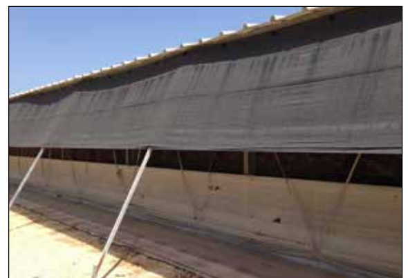
Figura 9. Las cortinas porosas bloquean la luz directa del sol dentro del galpón, pero permiten que pase el aire.
