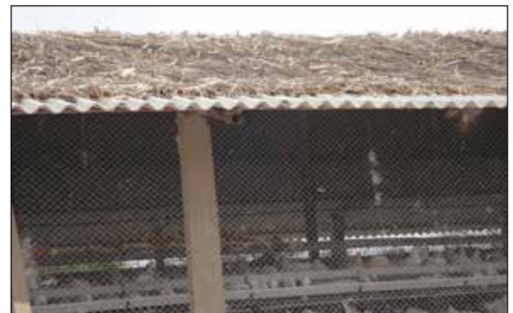
Figura 8. Utilice paja (paja, tallos de maíz, caña de azúcar) para reducir el calentamiento del techo.
