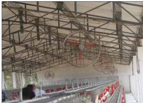
图4. 搅拌风扇和喷雾器可以增加舍内风速并且有较好的降温效果。
