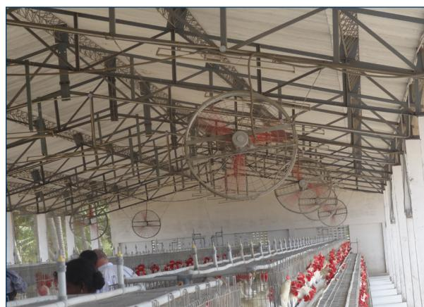
شكل 4. تزيد المراوح و أجهزة الضباب من سرعة الهواء و تبريد داخلي العنبر.
