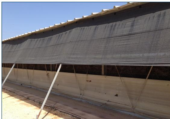
شكل 9. مظلات مسامية للنوافذ تحجب ضوء الشمس المباشر، لكن تسمح بمرور الهواء لداخل العنبر.
