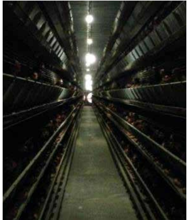
图18. 鸡舍中安装的LED等定向性太强、距离太远并且亮度不够。这些因素结合在一起导致地面上很明显的阴暗以及鸡笼光照均匀度很差。
