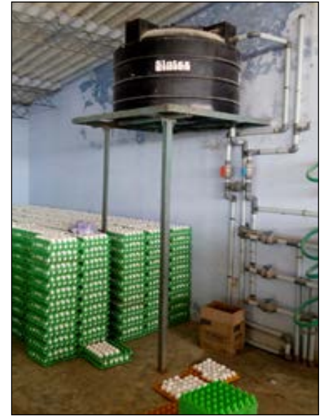
Рисунок 12. Наличие водяного бака внутри птичника сохраняет воду прохладной.
