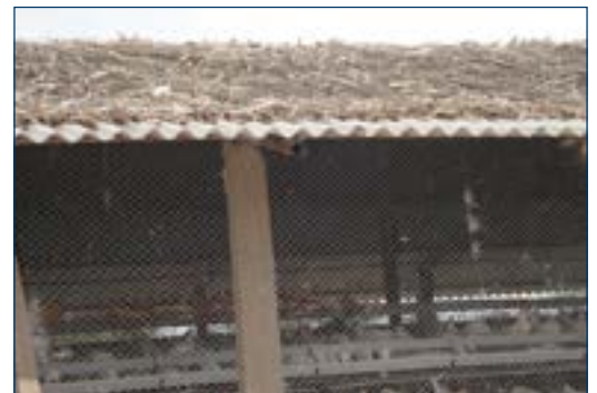
Figure 8. Utilisation de matériaux de paillage (paille de riz, rafles de maïs, fanes de canne à sucre) pour réduire le réchauffement solaire du toit.
