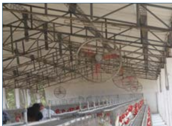
Figure 4. Les ventilateurs et brumisateurs augmentent la vitesse d'air dans le bâtiment et créent un effet de refroidissement.
