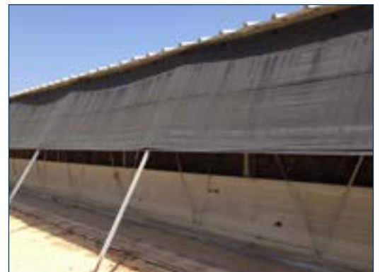
Figure 9. Volet/filet empêchent la lumière directe du soleil d'entrer dans le bâtiment, mais laissent passer l'air.
