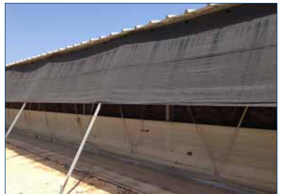
图9. 透气的遮光罩，既可以挡住阳光直射鸡舍，又可以让气流通过。
