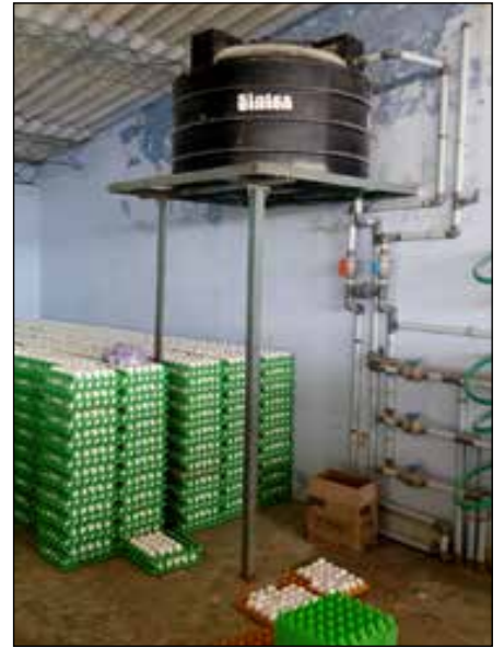
图12. 将水箱放在鸡舍内可以保持较低的水温。
