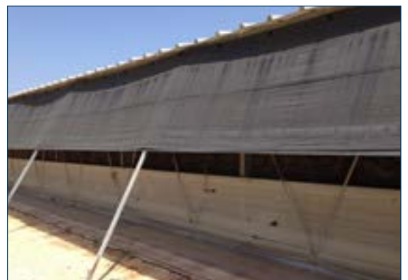
图9. 透气的遮光罩，既可以挡住阳光直射鸡舍，又可以让气流通过。
