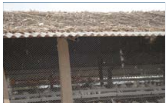
图8. 屋顶覆盖茅草类材料（稻草、玉米秸秆、甘蔗杆尖）以防止太阳光晒热屋顶。
