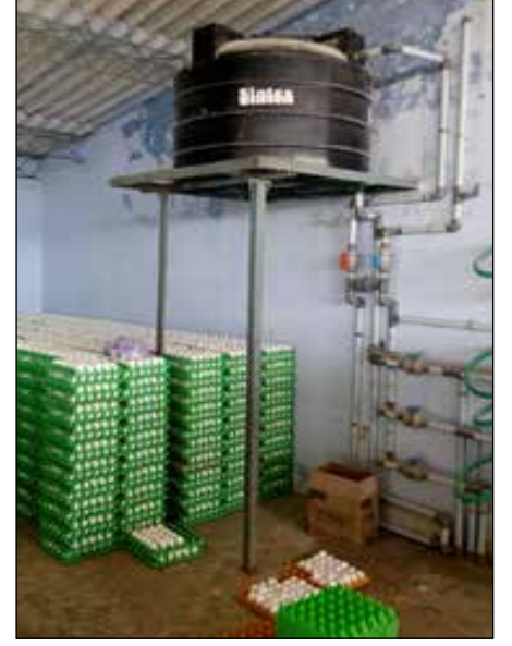
شكل 12. تركيب خزانات المياه داخل العنابر للحفاظ على برودة المياه.
