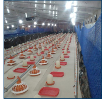
Civciv yerleştirilmesi öncesinde doğrulanmış doğru ve homojen ışık dağılımı.
