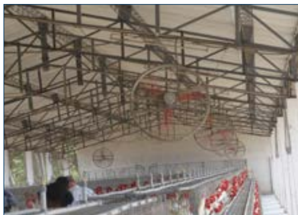
Figura 4. Ventilatori e nebulizzatori incrementano la velocità dell'aria e creano un effetto di raffrescamento.
