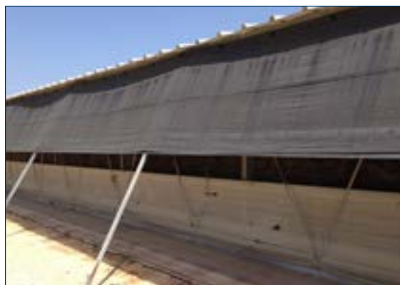
Figura 9. Teli porosi scuri impediscono alla luce solare diretta di entrare nel capannone e consentono il passaggio dell'aria.
