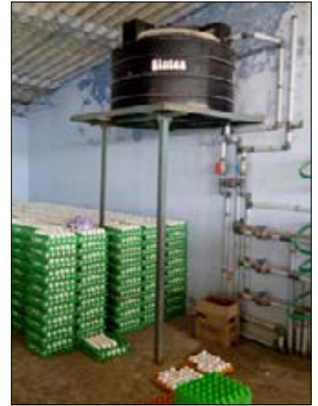
Figura 12. Los tanques de agua dentro del galpón mantienen el agua fresca.
