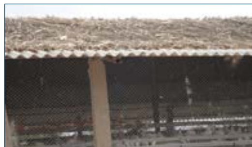
Рисунок 8. Используйте материал из соломы (рисовая солома, кукурузные стебли, верхушки сахарного тростника) для уменьшения солнечного нагрева крыши.
