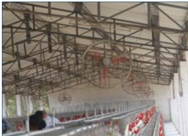
Рисунок 4. Вентиляторы и аэрозольное орошение увеличивают скорость воздуха внутри птичника и создают охлаждающий эффект.
