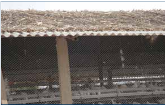
شكل 8. إستخدام القش ( قش الأرز، سيقان الذرة، رؤوس قصب السكر) لتخفيف تسخين الشمس للسقف.
